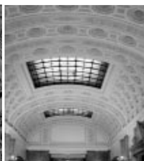
写真30 御休所前廊下天井石膏装
