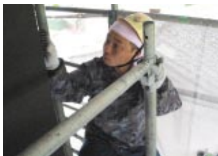
乾燥のタイミングを見て、剣山で掻き落とす。掻き落としをする平山真也さん。
