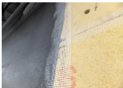
断熱ボードにカチオン性樹脂モルタルでメッシュを伏せ込み、下地を作る。
