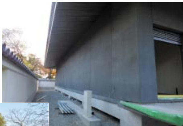
左官工事を終えた鶴林寺収蔵庫外壁
