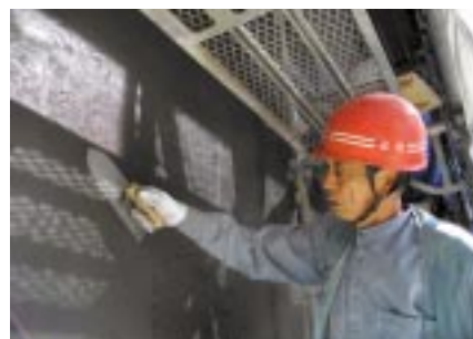
下地が軟らかいうちに上塗りをかけ、下地と一体化させる。塗り付けをする品川房男さん。
