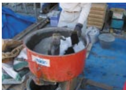
仕上材には、イタリア漆喰「ラスチコ」とセメントを1：1の割合で混ぜ合わせたモルタルを使用した。「メイン(バイエル)」で墨色に着色。
