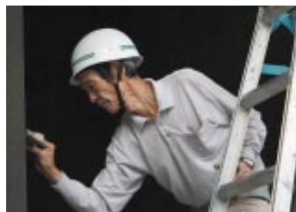
最後にドライウォッシュブラシで表情に変化をつける。手製のブラシで細部を整える品川清志さん。
