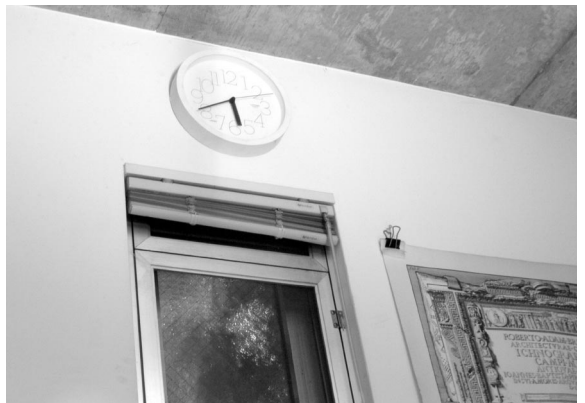
内壁には発泡ポリスチレン断熱材が張られている。
