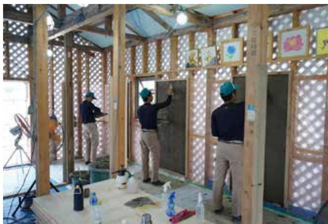
▲入校した訓練生は、左官の基本である壁を平滑に塗ることを覚える。訓練のポイントは塗る速さではなく、仕事の精度を求めていく。
