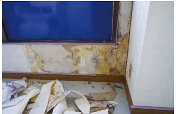
写真1 汚れの激しい箇所についてはクロスを剥がして新たに石膏ボードを取り付けていく
