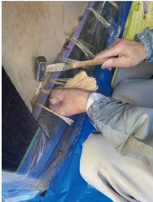
▲チリすきを防ぎ壁の剛性を増すため布連とチリトンボを施工する
