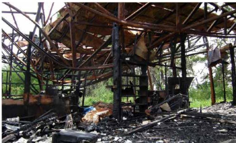
図1 不燃材の小屋組、可燃材の柱で構成された建物の火災後の様子
