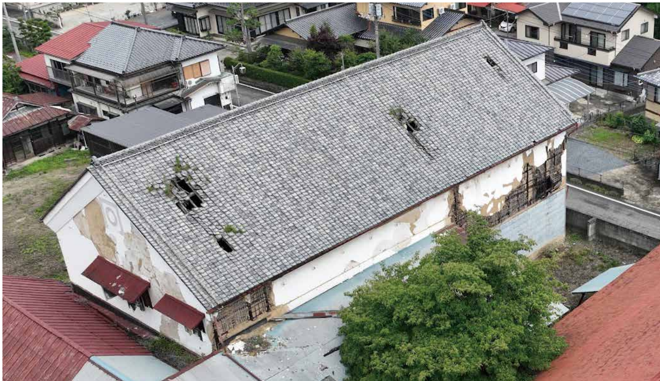
▲倒壊の恐れがある為、事前にドローンで上空からの空撮及び測量調査を行い、過去に施工した寺社の漆喰工事、川越市文化財復元工事の経験をもとにお客様への具体的な提案からスタートした。
