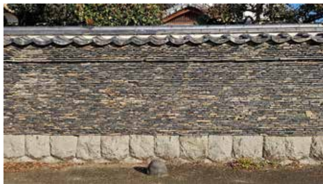
図2 高知県安芸廓中の瓦塀
