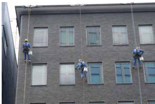
写真2 ブランコによる外壁タイル点検
