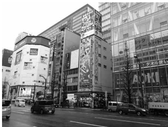
写真1 補強工事前の第5電波ビル(中央)
