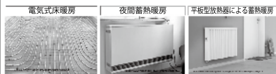
図3 電力による直接暖房
