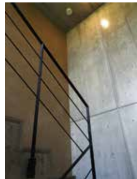
コンクリートと左官仕上げ。ツートンカラーの階段室。
