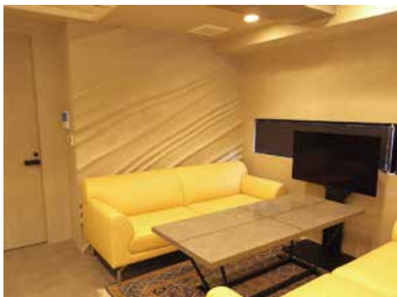
応接室。壁、床はもちろん、天井、扉やテーブルの天板まですべて左官。テーブル天板は「エクストン」の研ぎ仕上げ。「アンティーク・モルタル」による、ブリーツ状のデザイン壁が印象的。
