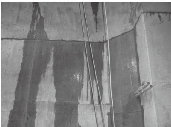
写真2 上部構造との打ち継ぎ部分からの漏水
