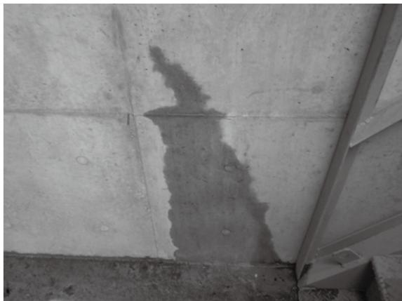
写真1 地下外壁のひび割れ部からの漏水
