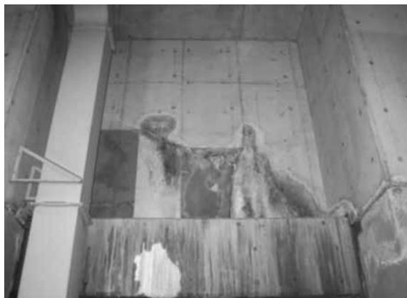
写真6 コールドジョイントからの漏水
