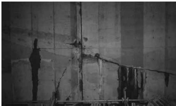
写真3 コールドジョイントからの漏水
