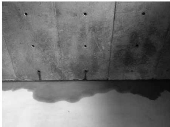
写真5 セパレーター部分からの漏水
