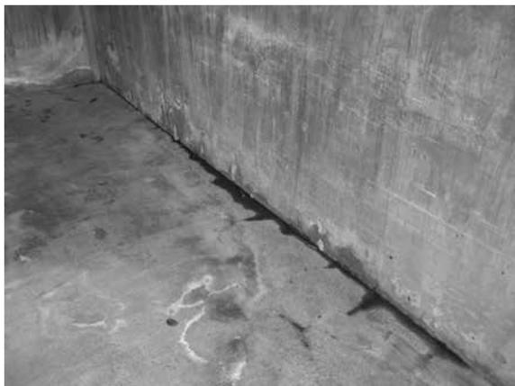
写真4 地下スラブと地下壁との接合部から漏水
