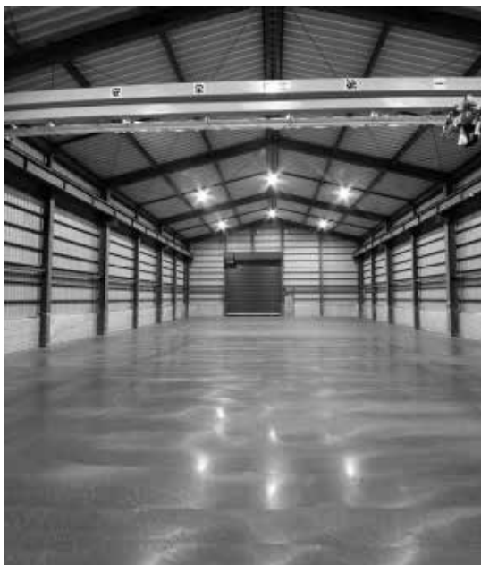
写真1 機械化施工を実施した床
