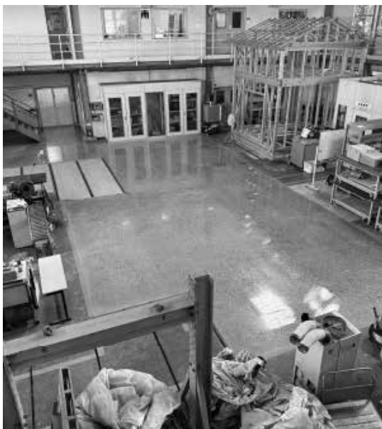
写真2 表面研磨仕上げを実施した床
