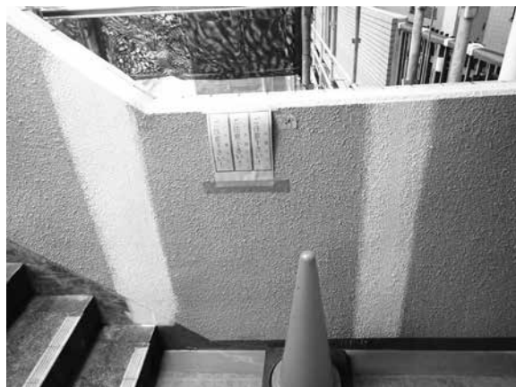
写真① 肌合わせ試験施工
